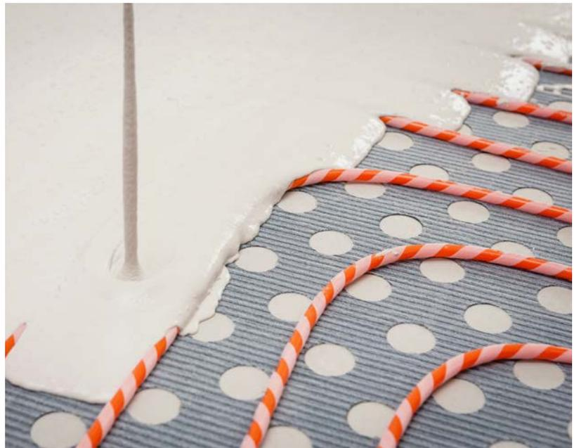
\* com 10 mm de argamassa autonivelante Thermio®Max de Anhydritec. Para mais informação, contacte o seu representante REHAU.
